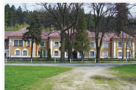
Obr. 8 Léčebna dlouhodobě nemocných Dvorce dne 6. 5. 2006, pohled od Nádražní ulice
