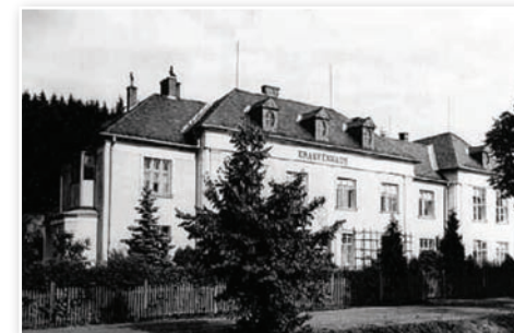
Obr. 4 Nemocnice po přestavbě z roku 1923, ještě před dostavbou z let 1931 – 1932
